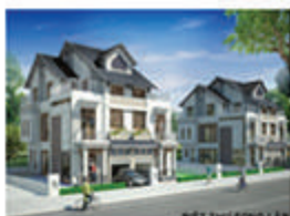
KHU NHÀ VƯỜN BÌNH NHÂM
